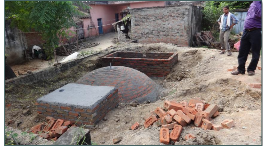
Biogasanlage
