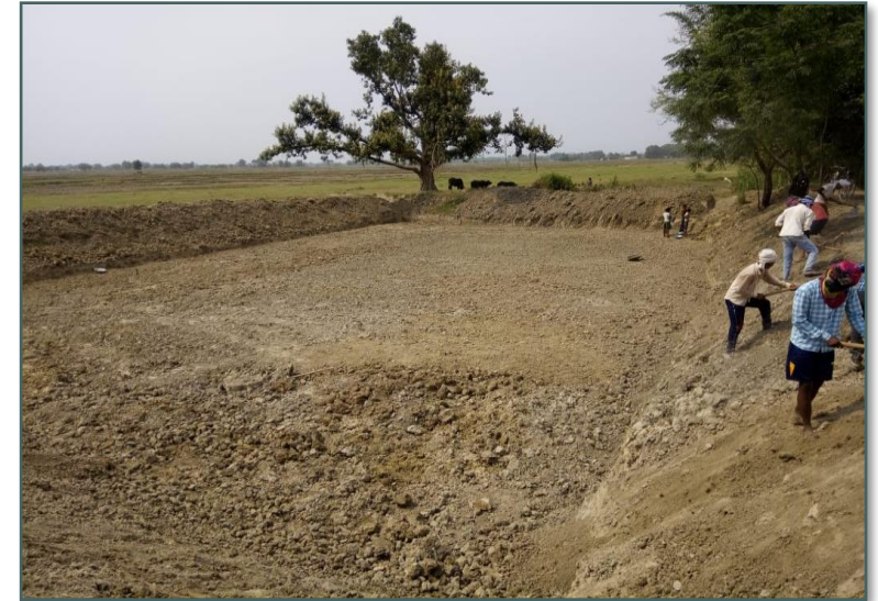
Errichtung Wasserbecken
