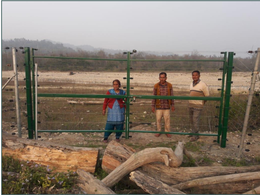
Solarbetriebener Elektrozaun im Dorf Dhela
